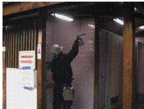
仕上げの施工をします
