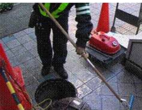
歩道に漏れた水も丁寧に除去
