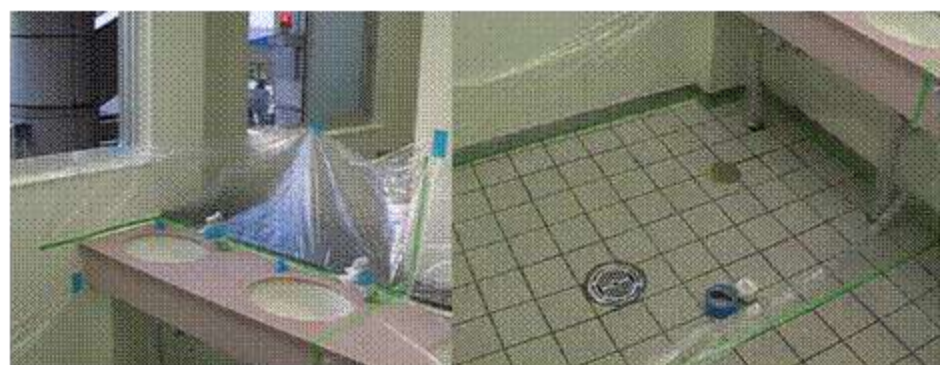
防汚対策で光触媒施工の為養生中 化粧品の汚れ予防対策で床面
