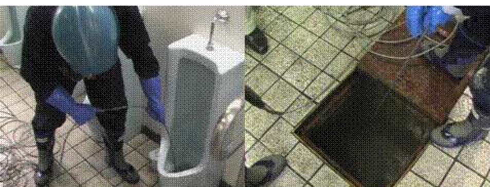
小便器の配管も高圧洗浄器使用 踊り場の大型配管も洗浄します
