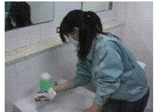
施工後仕上げも丁寧にします
