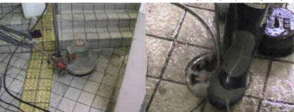
フロアを清掃器具で洗います 高圧の温水を足でカバーして洗浄
