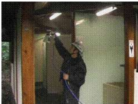
入り口の壁面にも施工します
