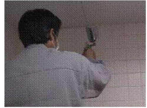
ブース内の天井も施工します
