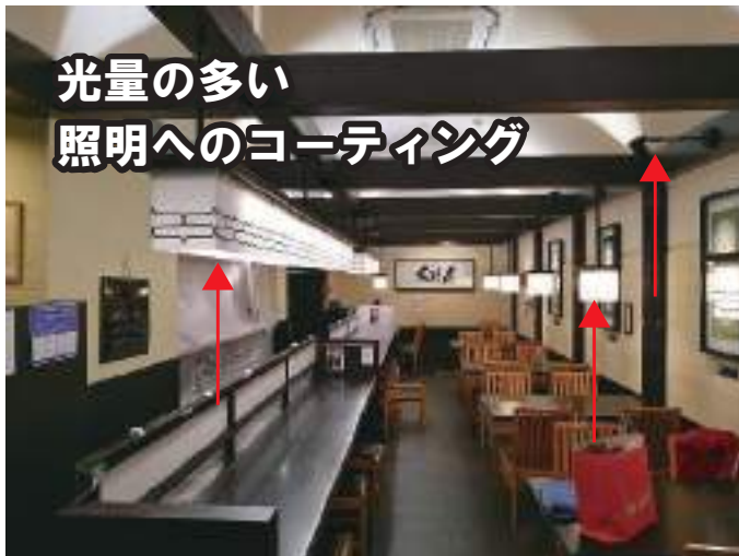
照明カバー、内側の照明にも直接コーティングしております。
