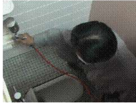
ブース内も丁寧に施工します
