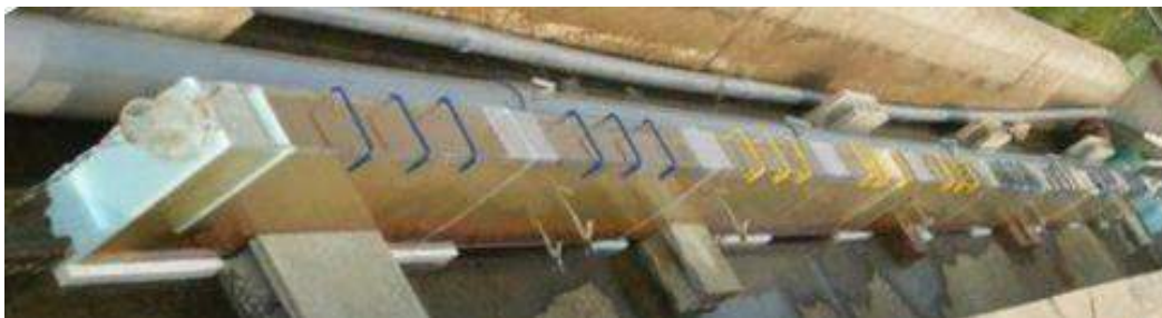
光触媒充填水路の全景
